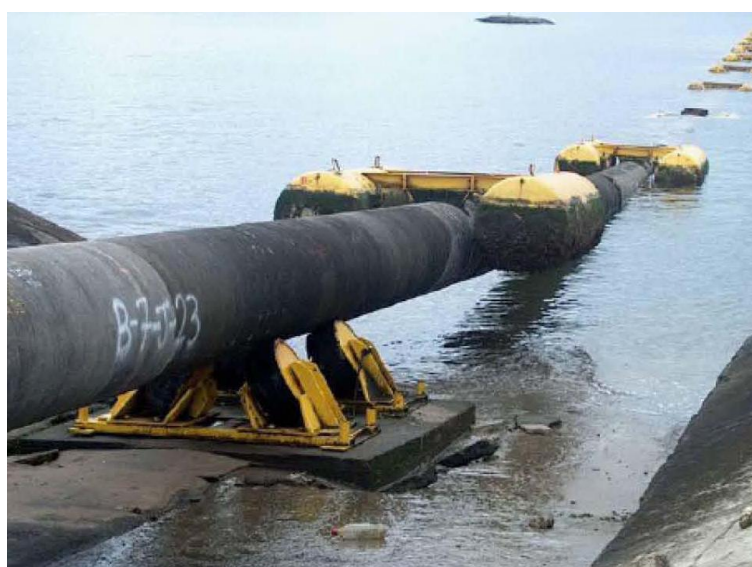
FOTO 8.5.2-1: Posicionamento da tubulação com flutuadores
