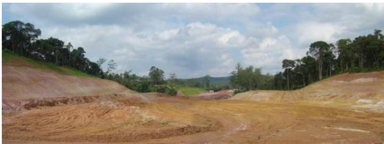
FOTO 10.1.1.3.2-21: Vista de corte de morro com exposição de sedimentos paleógenos associados à Bacia de São Paulo. Os depósitos ocorrem como manchas isoladas e descontínuas recobrando rochas metamórficas do Complexo Embu. Exposição de taludes do Trecho Sul do Rodoanel
