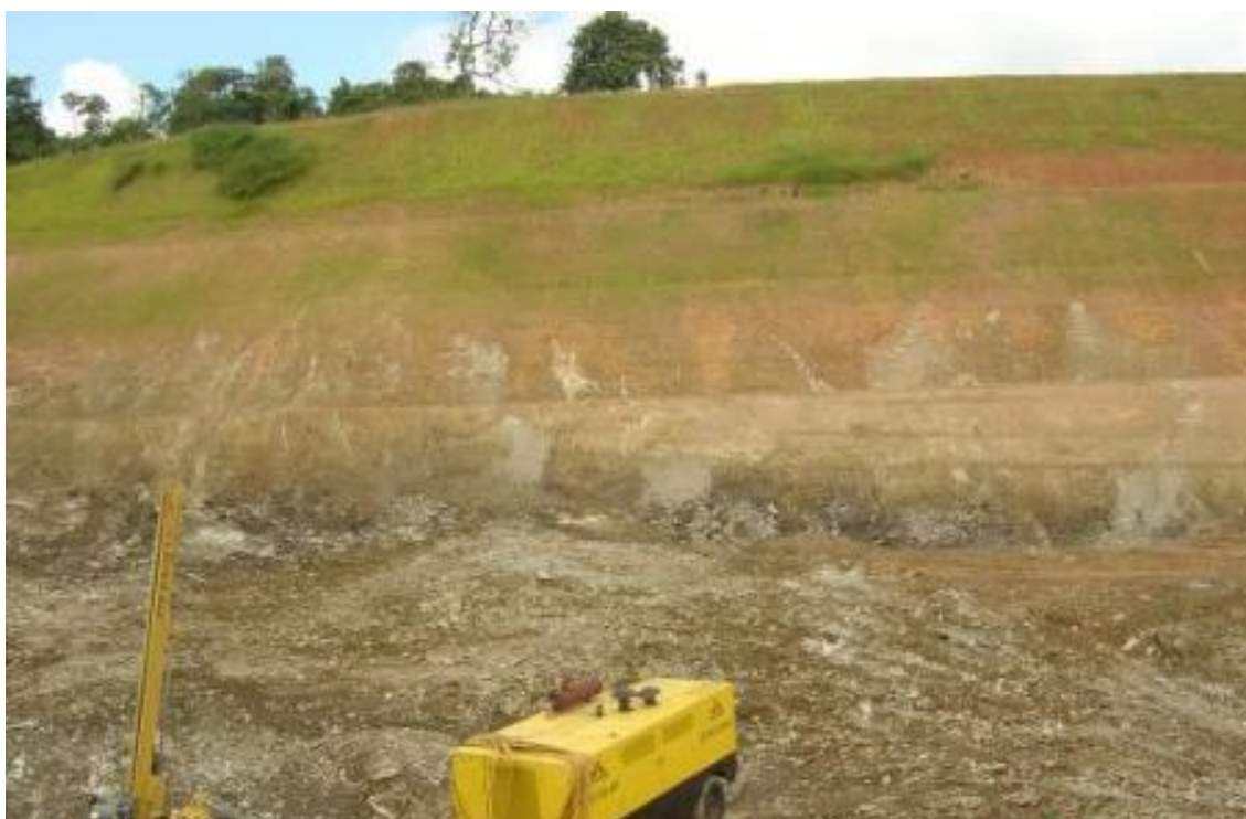
FOTO 10.1.1.3.2-10: Vista de retaludamento de morro alto com exposição de rochas metamórficas de alto grau – gnaisses localmente migmatizados, associações de biotita milonito gnaisses porfiroclásticos e corpos subordinados de biotita ortognaisses – do Complexo Embu (NPegg, Domínio Embu), expostos em corte de talude do Rodoanel – Trecho Sul. Região da estaca 130+500m
