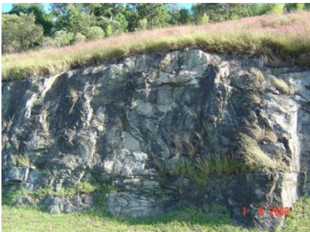
FOTO 10.1.1.3.2-44: Detalhe de corte de morro alto para a implantação da Rodovia dos Bandeirantes, com a exposição de gnaisses do Complexo Piracaia (NPpigpa) (Domínio Socorro-Guaxupé) no sopé da Serra do Japi. Arredores da estaca 65. Município de Jundiaí
