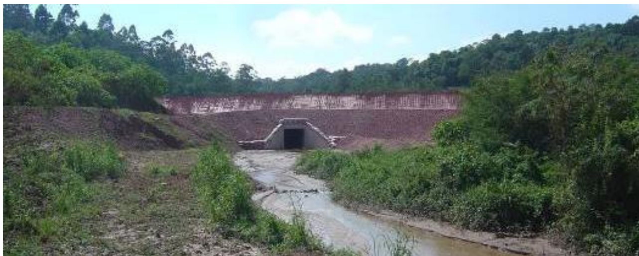
FOTO 10.1.4.3.2-15: Ocorrência restrita da Unidade Geotécnica 13 reconhecida no Planalto, associada a uma drenagem secundária atravessada pelo Trecho Sul do Rodoanel. Nestes locais – previamente à implantação dos aterros do Rodoanel – podiam ocorrer processos de inundações e adensamento de solos moles, sendo que tais locais apresentavam alta suscetibilidade às inundações, recalques, assoreamento e solapamento das margens dos rios
